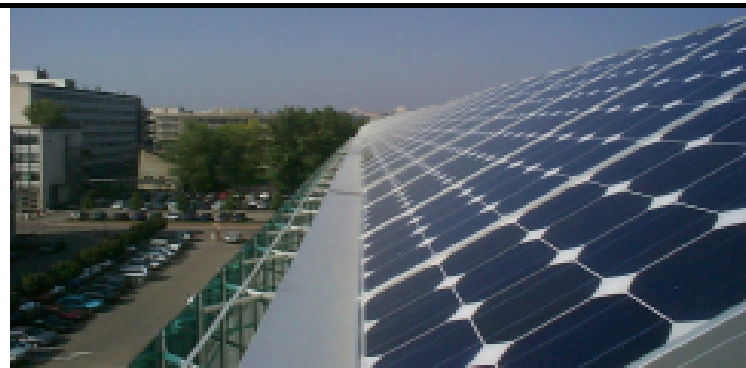
Exemple de sur imposition en toiture terrasse
