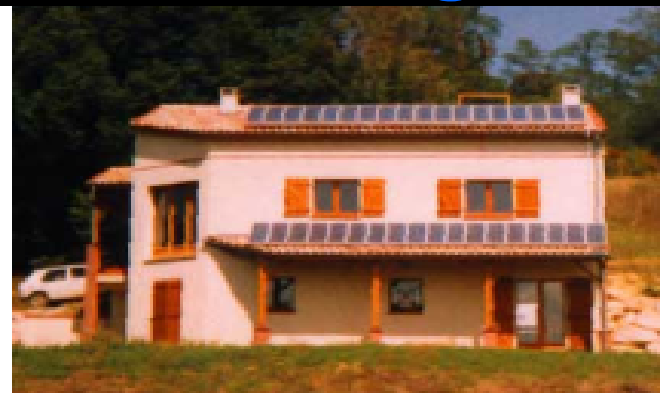
Exemple de sur imposition en toiture inclinée
