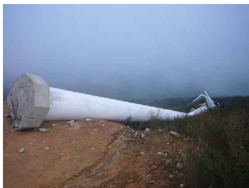
机组基础破坏后风电机整体倾倒
