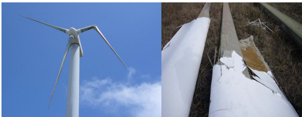
损坏的V42叶片
