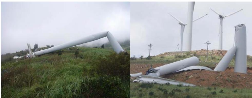
风机塔架折断
